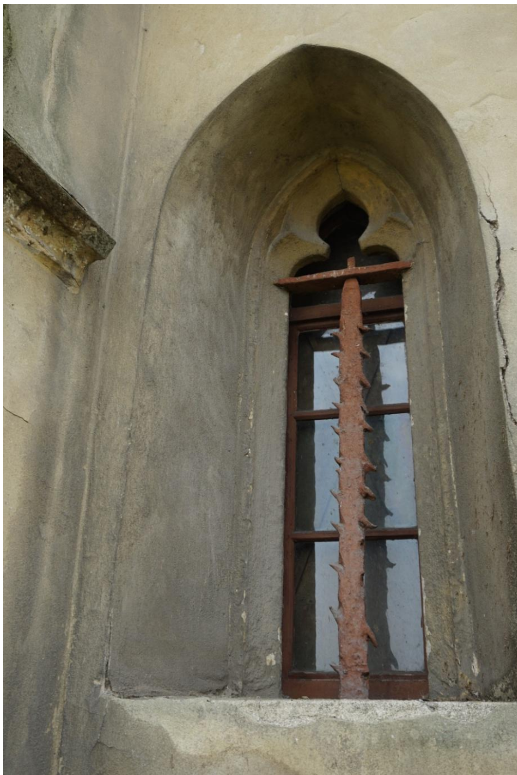
Lomený oblouk pískovcového okna. Středový kovaný prut mříže s hroty. Pískovec natřen vrstvou nátěrů, včetně současného fasádního nátěru.
