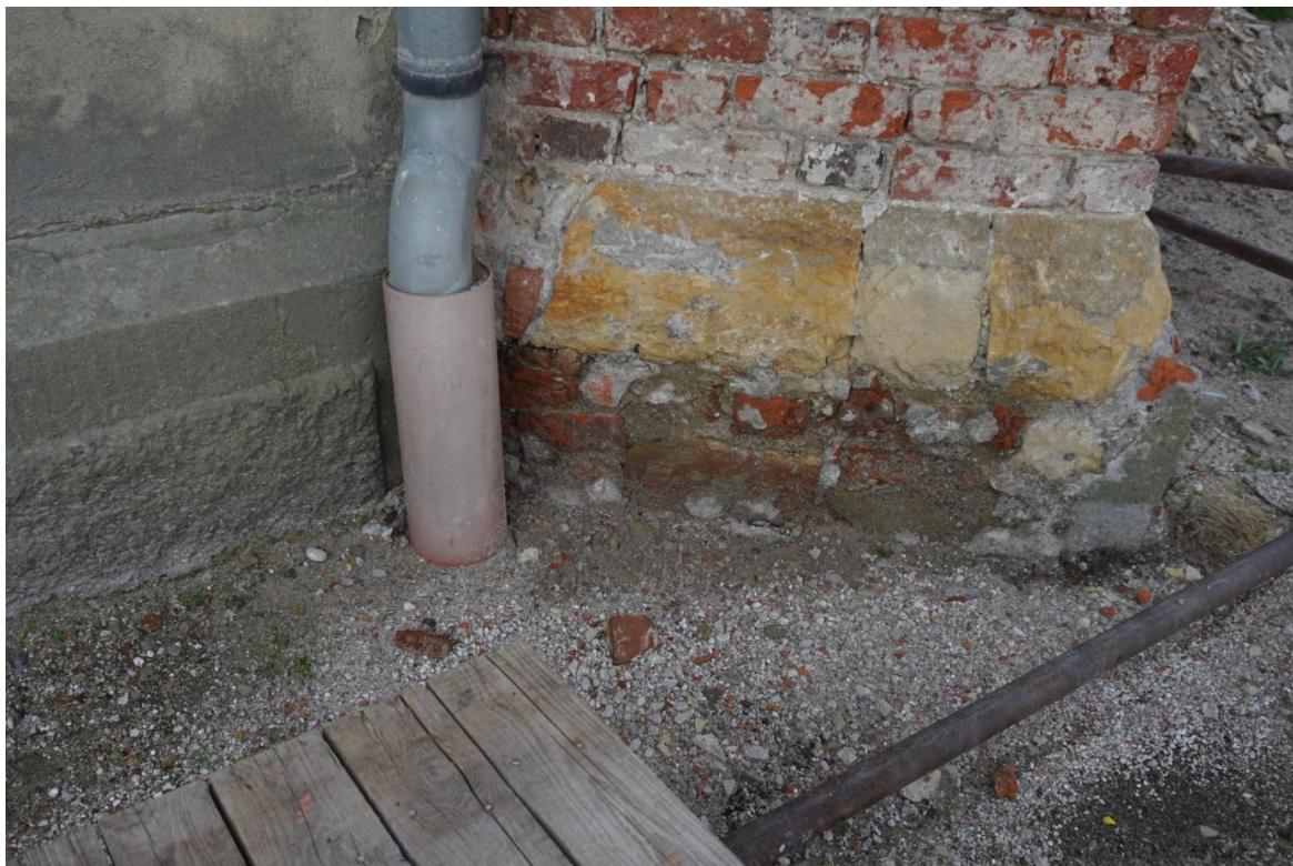
SZ fasáda hlavní lodi. Pískovcový sokl s cementovou omítkou // Pískovcový sokl po očištění. + cihlové zdivo.
