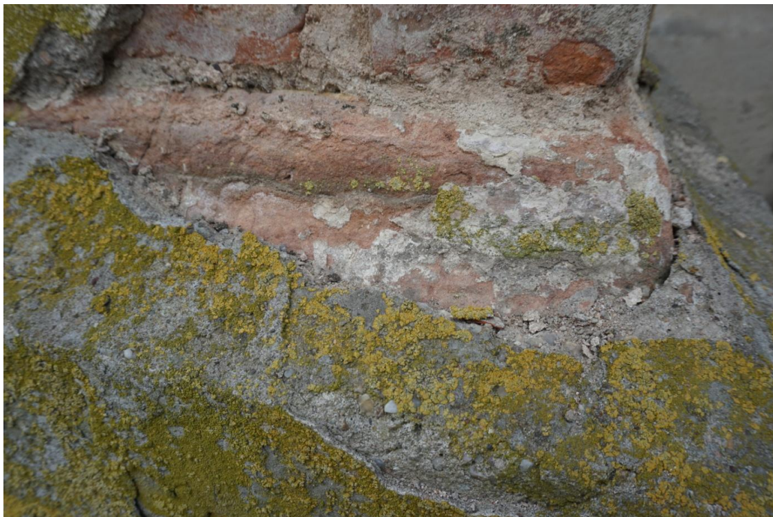
Sokl hlavní lodi. Pod vrstvou strukturované cementové malty načervenalý vrchní profil z pískovcových kvádrů, plochy jsou vyzděny z cihel. Na povrchu pískovce fragmenty vápenných nátěrů.
