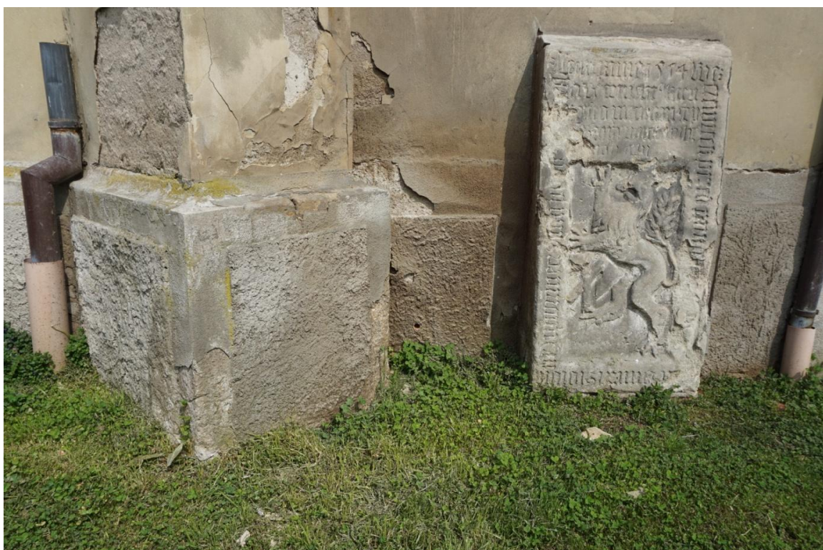
J fasáda kostela. Sokl hlavní lodi. Pod vrstvou strukturované cementové malty vrchní profil je z pískovcových kvádrů, plochy jsou vyzděny z cihel.
