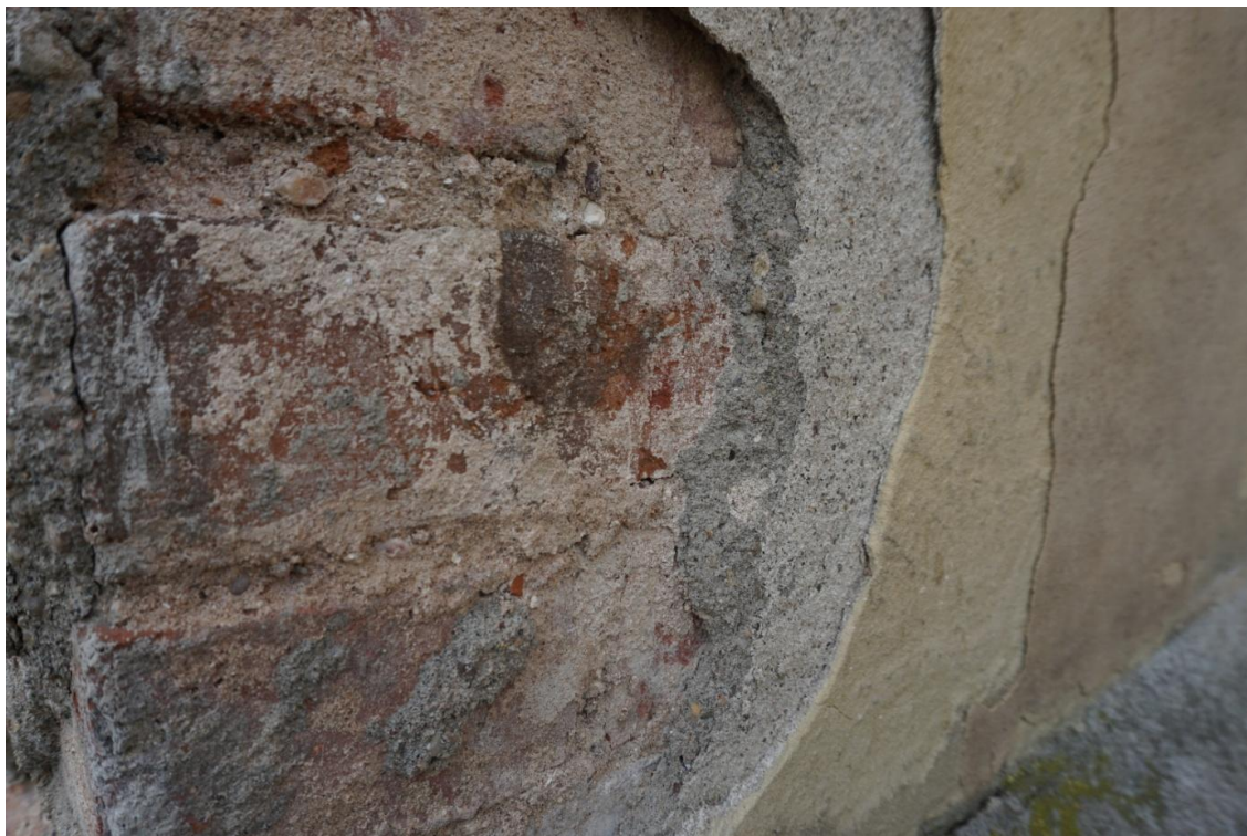
Sonda nad pískovcovým soklem opěrného pilíře. 0 – cihlové zdivo, 1 – jádrová omítka, 2 – opravná štuková omítka, 3 – nátěr (světlý okr), 4 - opravná štuková omítka, 5 –současná barevnost.
