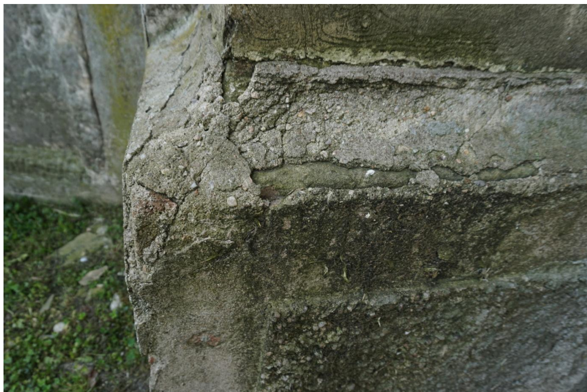
Detail poškození soklu.
