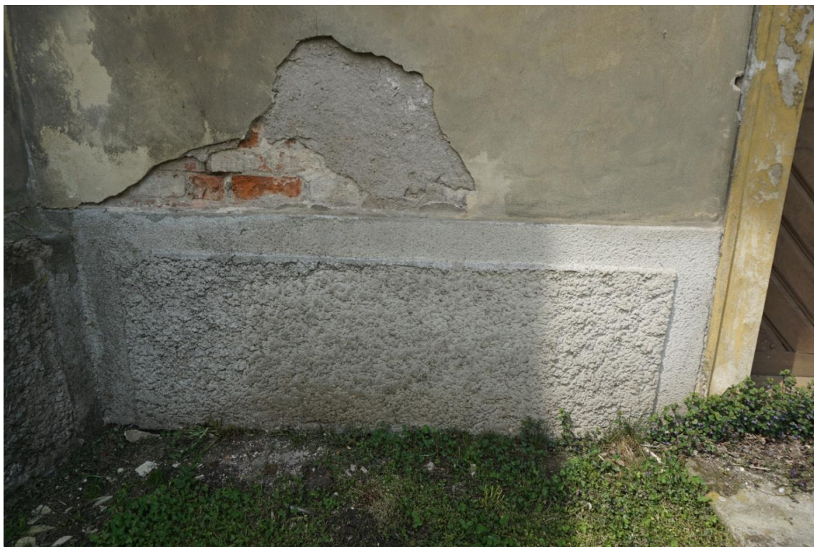
Nastříkaná cementová omítka s hrubou frakcí křemičitého písku. Obvod jednotlivých segmentů pískovcového soklu lemuje hladký pásek.
