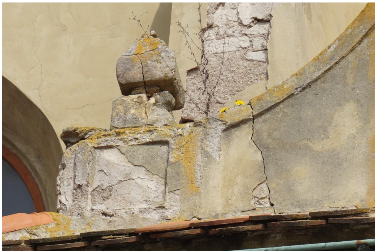
Na štítu prasklý pískovcový prvek pravděpodobně vlivem koroze čepu. Havarijní stav!
