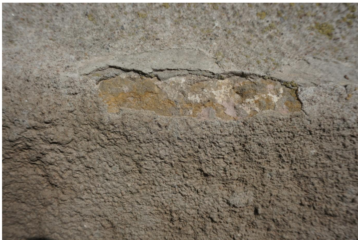
Detail povrchových vrstev pískovce.
