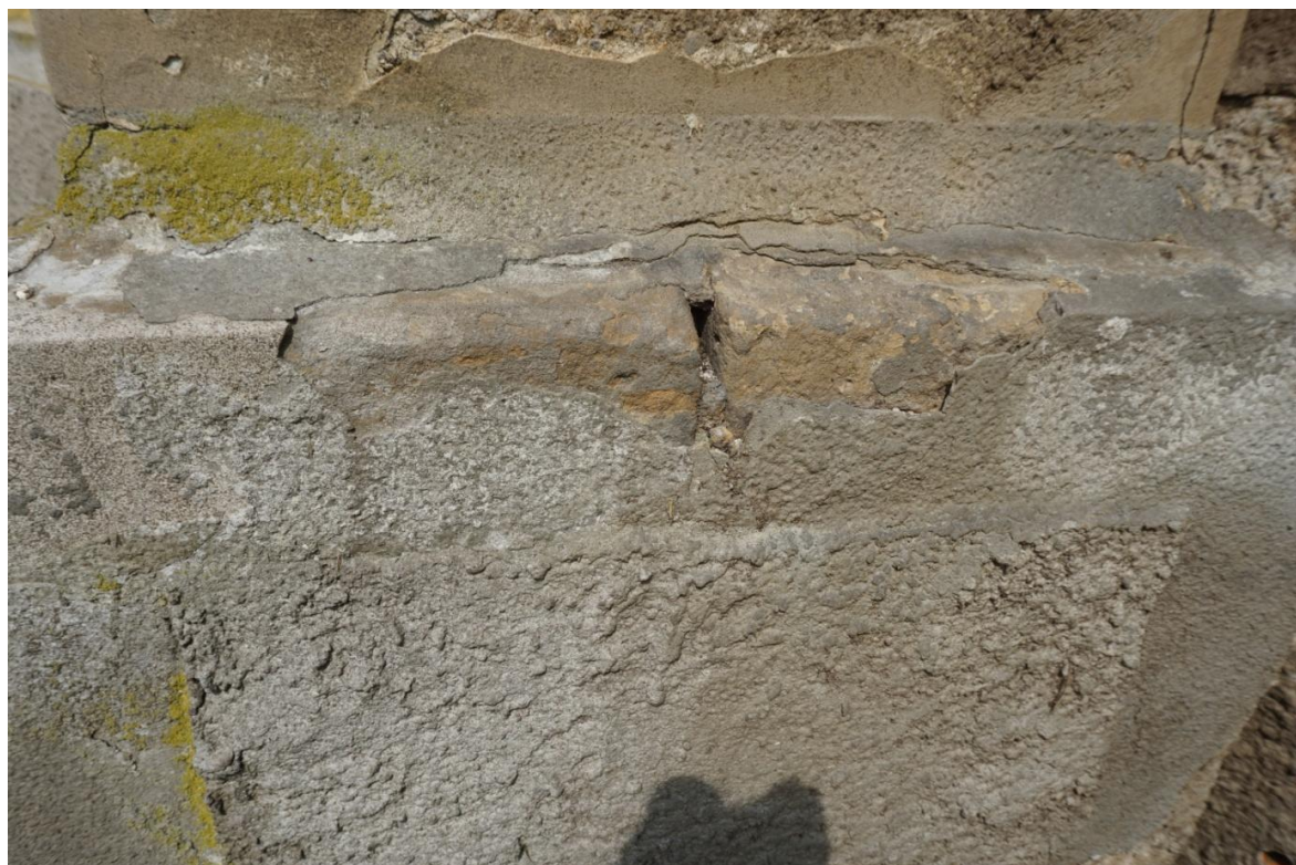
Sokl hlavní lodi. Pod vrstvou strukturované cementové malty vrchní profil je z pískovcových kvádrů, plochy jsou vyzděny z cihel.
