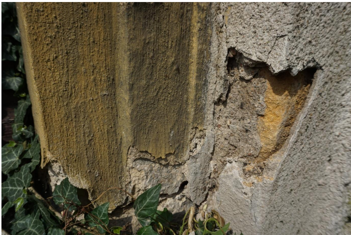
Pískovcový portál a sokl pod vrstvami omítek a cementu.
