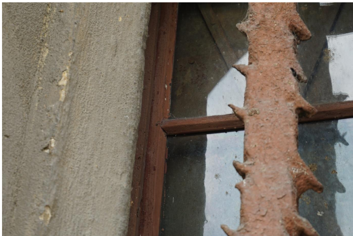
SV fasáda kostela (zákristie). Detail. Lomený oblouk pískovcového okna. Středový kovaný prut mříže s hroty. Pískovec natřen vrstvou nátěrů, včetně současného fasádního nátěru.
