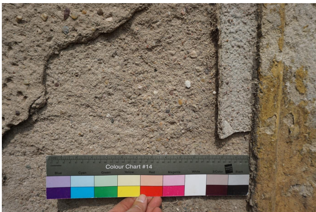
Sokl kostela. Detail křemičité frakce cementové vrstvy.
