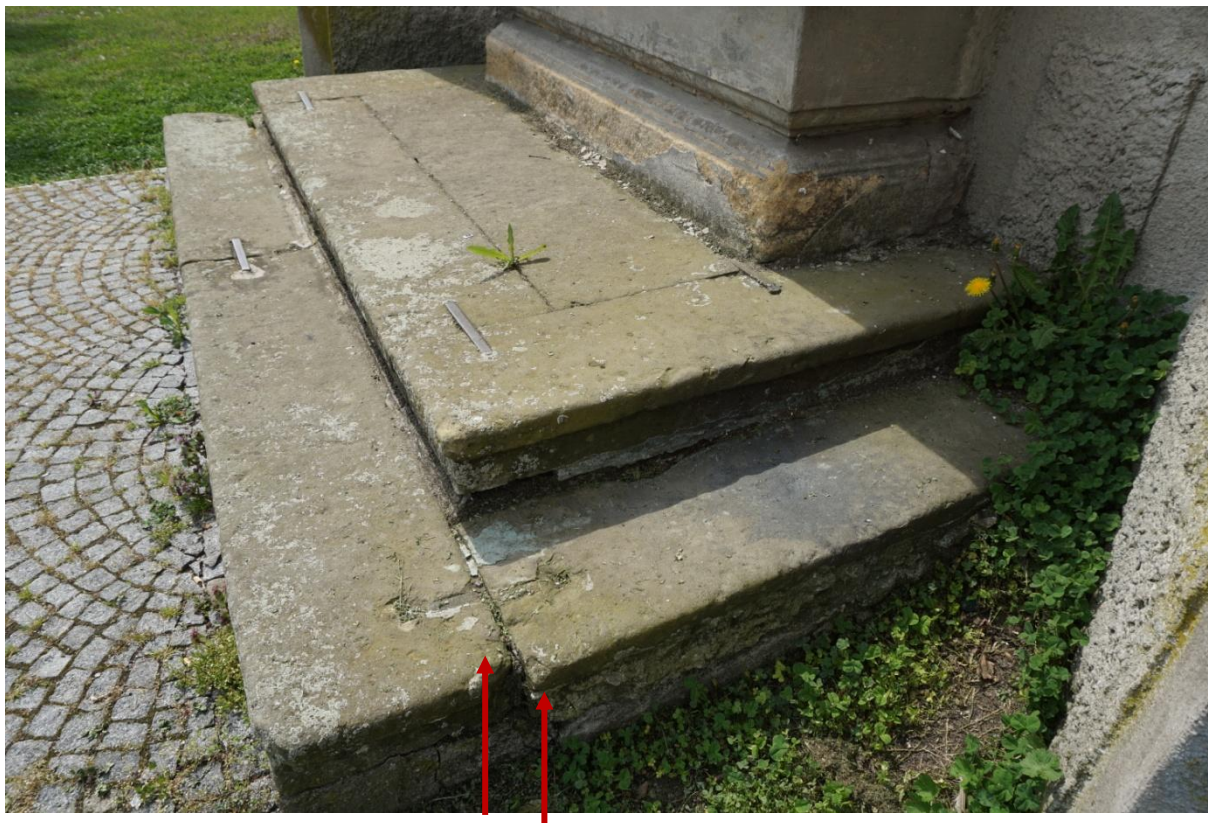
V fasáda kostela (presbytář). Pískovcová menza. Detail poškození. (První stupeň schodiště v bocích vystupuje přes rovinu čelního schodu. Uvolněné spáry – chybějící kovové spony. Biologické a prachové depozity Povrch pískovce přetažen cementovým nátěrem.
