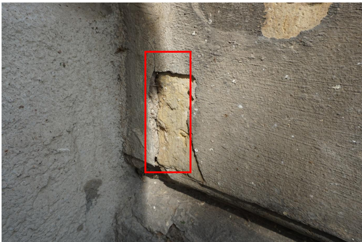
Oltářní menza. Pískovec přetažený neprodyšným cementovým tmelem.
