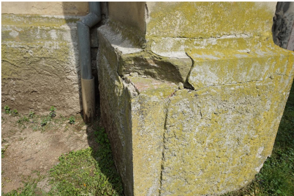
Sokl opěrného pilíře. Pod vrstvou strukturované cementové malty, po obvodu hladké plochy. Vrchní profil je z pískovcových kvádrů, plochy jsou vyzděny z cihel.
