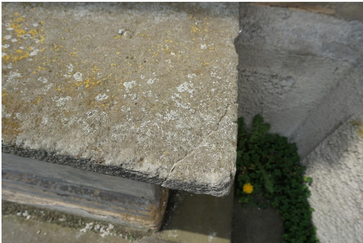
Detail poškození pískovcové menzy.
