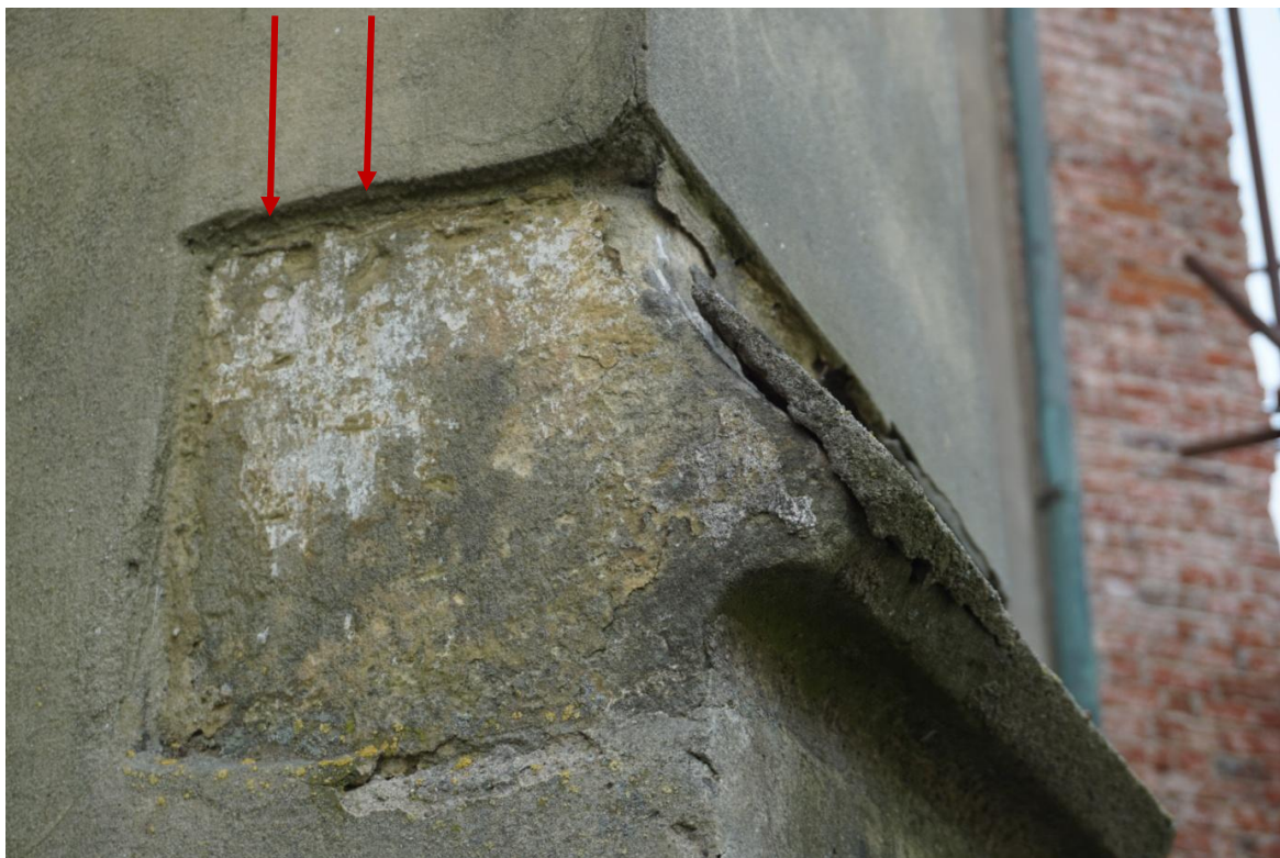
SZ fasáda hlavní lodi. Pískovcový prvek fasády kostela ošetřený okrovým nátěrem. Přejechod navrstvené omítky vytváří esteticky rušivý detail! Omítka by měla plynule navazovat na plochu pískovce bez navrstvených hran. Detail poškození pískovcové hrany.
