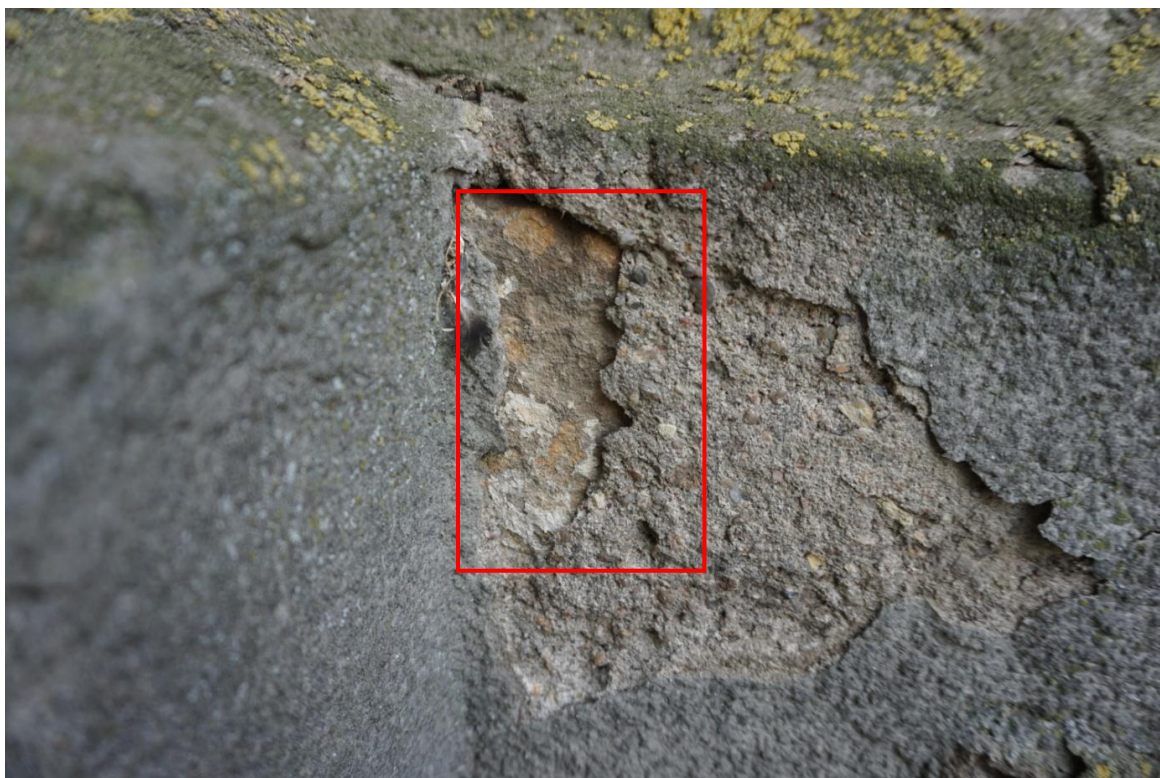
Detail pískovce soklu pod cementovou vrstvou.
