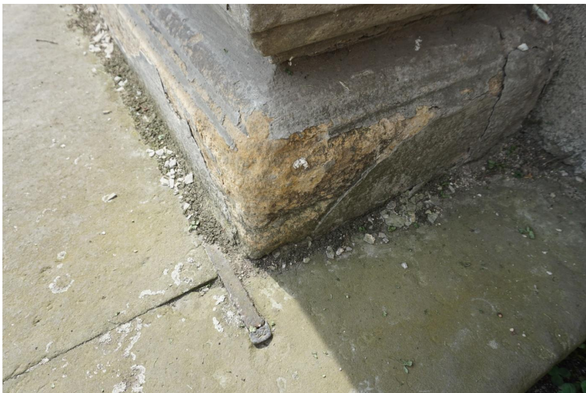
V fasáda kostela (presbytář). Pískovcová menza. Detail poškození. (První stupeň schodiště v bocích vystupuje přes rovinu čelního schodu. Uvolněné spáry – chybějící kovové spony. Biologické a prachové depozity Povrch pískovce přetažen cementovým nátěrem.
