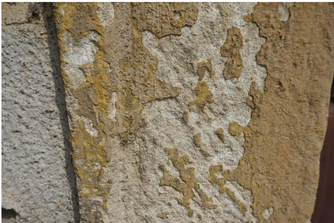
Detail povrchových vrstev pískového portálu. 0-pískovec, 1- vápenný nátěr (okr), 2 – současný nátěr (zemitější odstín).
