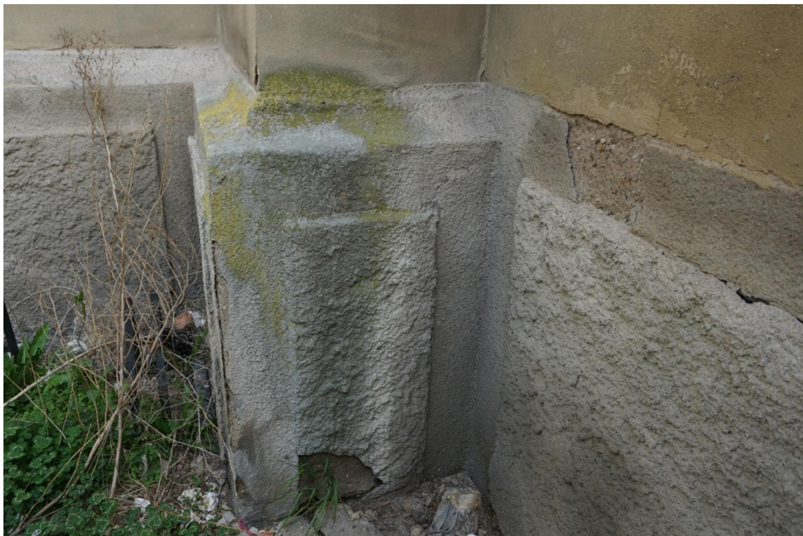
Pískovcový sokl hlavní lodi. 0-pískovec, 1- vápenný nátěr (bílá) , 2 – vápenný nátěr (zemitější odstín - béžová), stříkaná cementová omítka. (imitace hrubozrnného pískovce).
