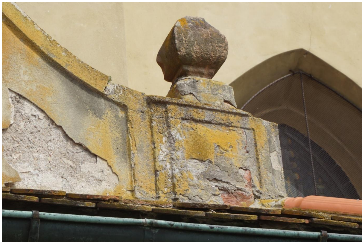
Poškozený pískovcový prvek na štítu.
