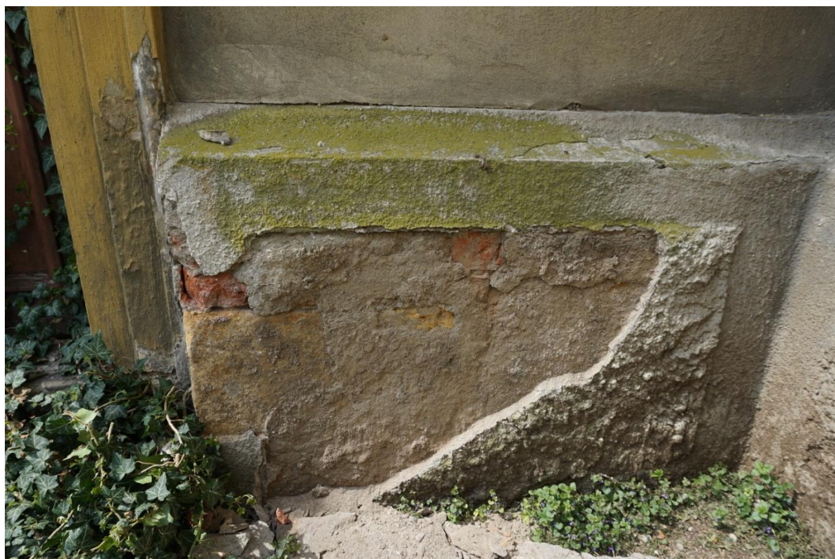
J fasáda jižní předsíně kostela. Pískovcový portál a navazující sokl ze smíšeného zdiva (cihla + pískovec).
